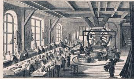
Vue d'une partie de l'atelier du rez-de-chaussée.
